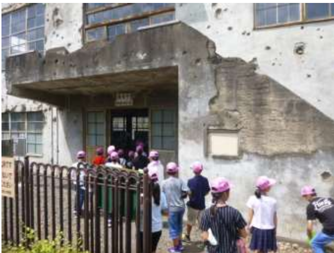
東大和市の旧日立航空機株式会社変電所を見学
