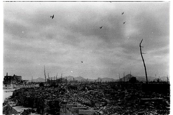
広島平和記念資料館提供 撮影／林重男 後の平和記念公園地区周辺
